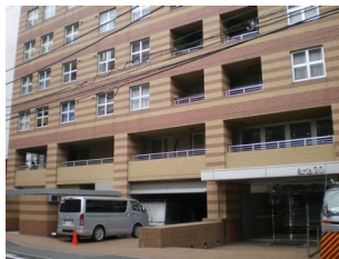
図2 マンション入口
